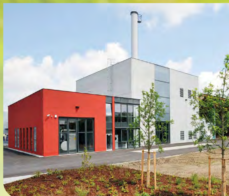
Biomasse-Heizkraftwerk und Fernwärmenetz in Dillingen
