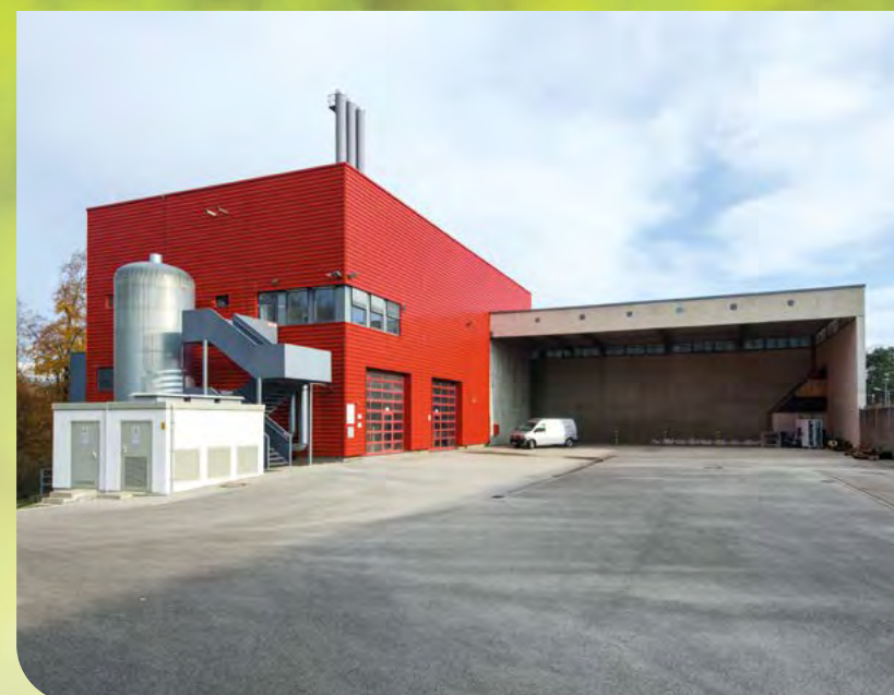
Biogas-Blockheizkraftwerk und Fernwärmenetz in Kaufbeuren
